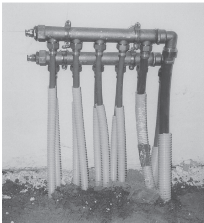
Fig. 29 : Nourrices ou distributeurs en vue de face
