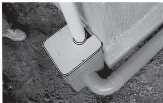
En pied de chute avec couvercle piéton.
